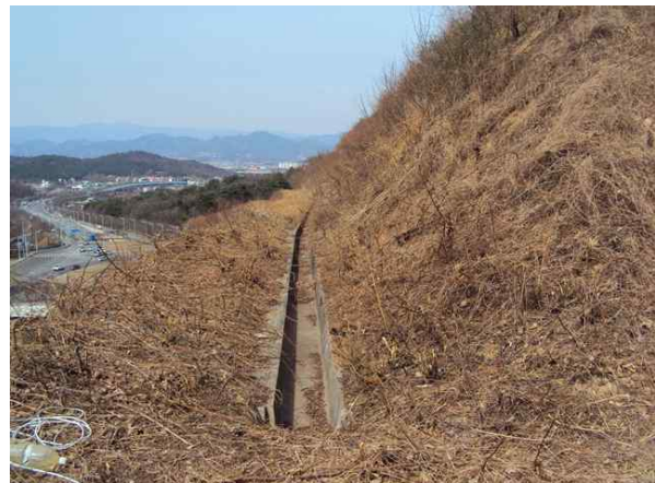
2소단 배수로 전경
