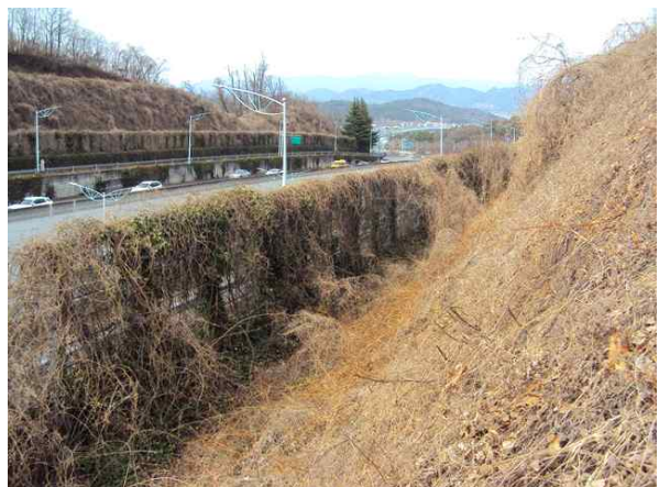
낙석방지울타리 및 하부 전경
